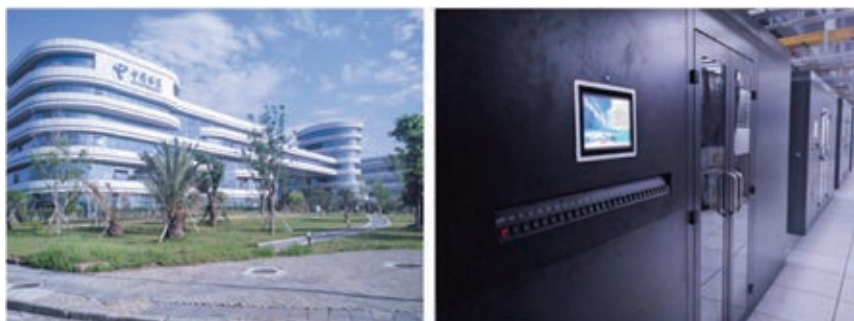
图 2 普天天纪微模块数据中心成功应用于重庆银行云计算数据中心
