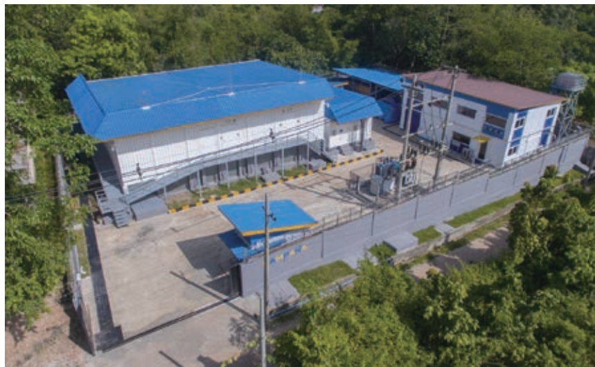
台达为新加坡 Campana 集团提供了总容量达 200kW 的模块化集装箱数据中心解决方案，用于建设连接新加坡和缅甸的最大的高速数据中心走廊——MYTHIC 国际海底电缆工程
