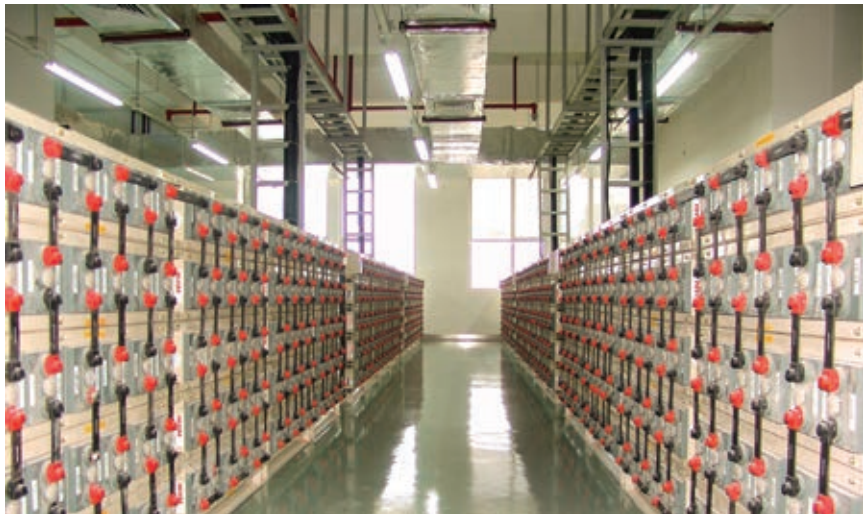
图1 免维护阀控铅酸蓄电池安装布置图
