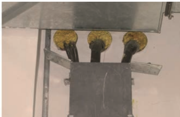
采用普通材料进行封堵
